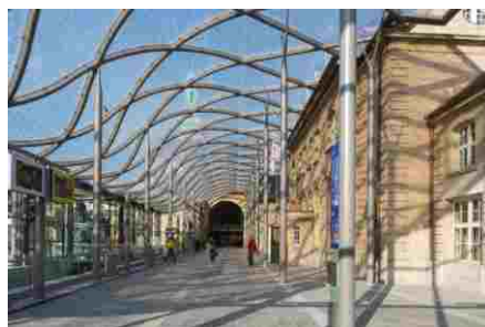
© Foto_Photo : INCA Ingénieurs Conseils Associés — Reizigershal van het station van Luxemburg
