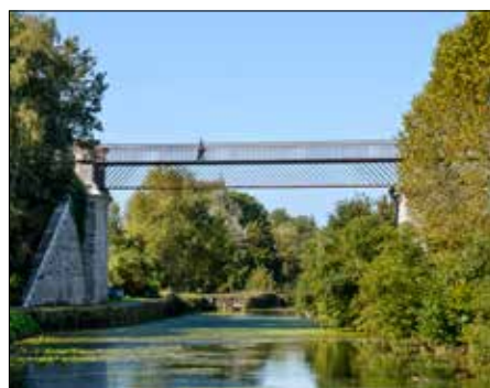
De passerelle in Arquennes - foto Greisch / JL-Deru
